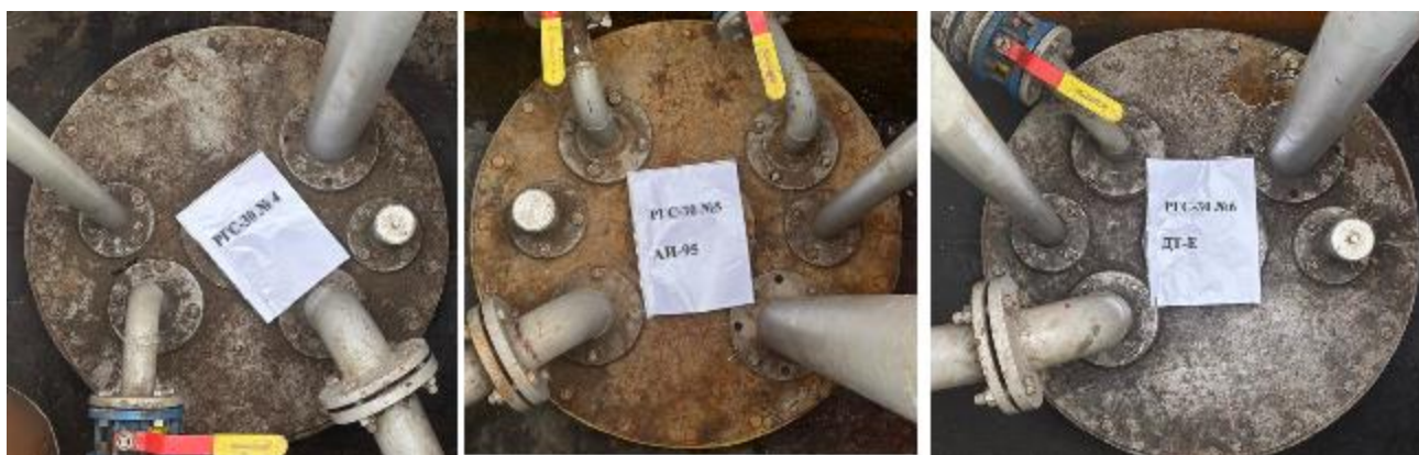
Рисунок 2 – Горловины резервуаров РГС-30 зав.№№ 4, 5, 6
