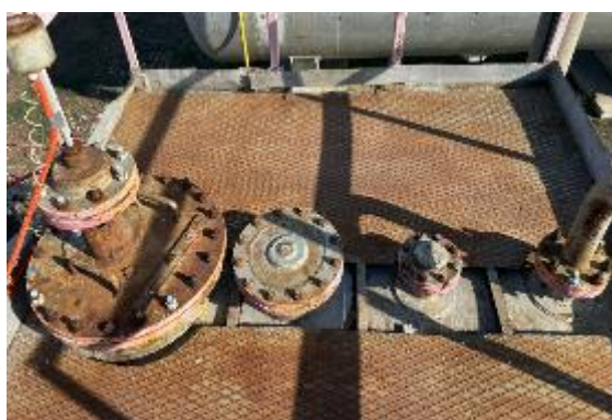
Рисунок 2 – Вид замерного люка и место нанесения заводского номера резервуара горизонтального стального РГС-60 заводской номер 7416
