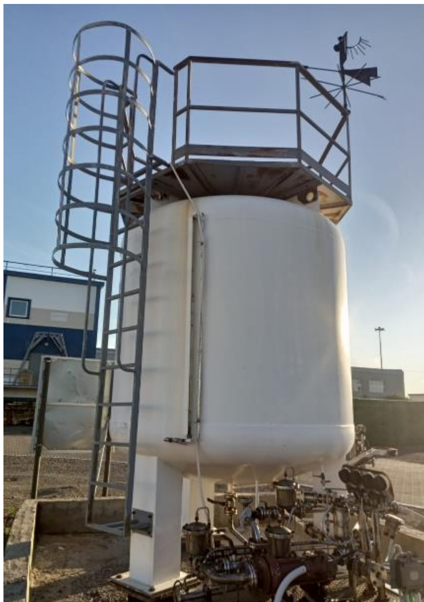
Рисунок 2 – Общий вид резервуара Рк-10 зав.№ 011
