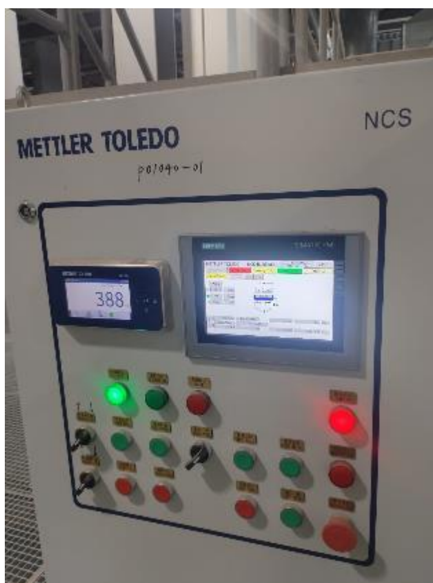
Рисунок 2 – Общий вид терминала IND360 и панели оператора – SIMATIC HMI
