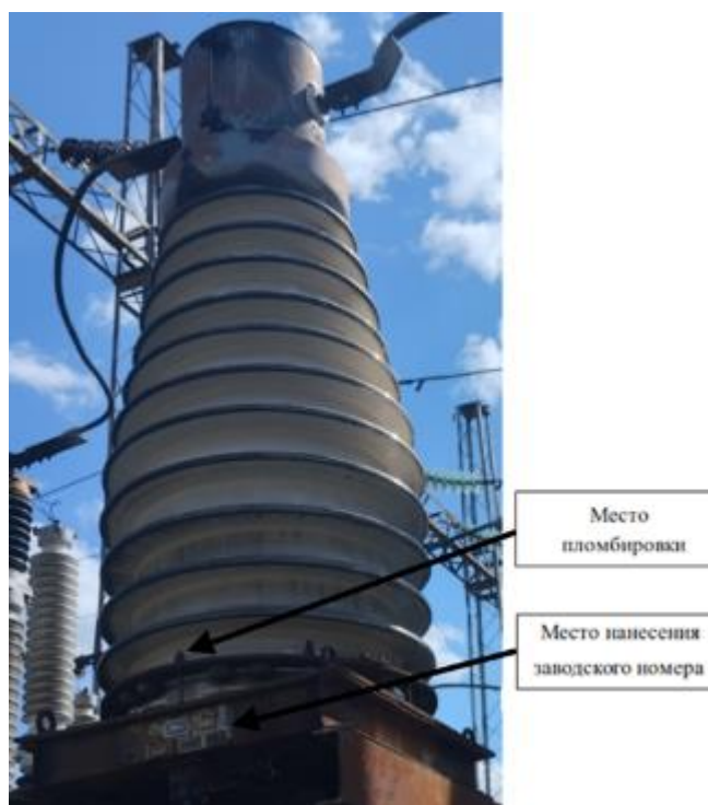
Рисунок 1 – Общий вид средства измерений с указанием места пломбировки и места нанесения заводского номера
