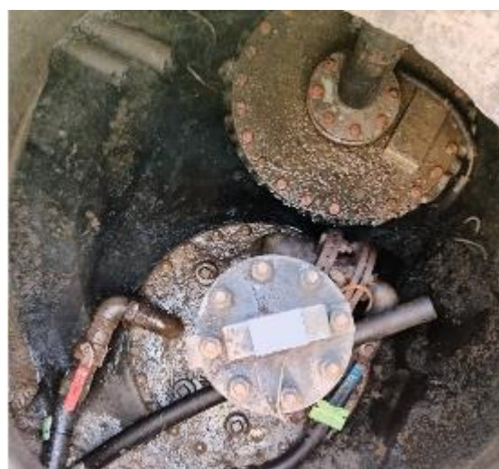
Рисунок 4 – Маркировочная табличка и горловины резервуара РГС-50 зав.№ 148
