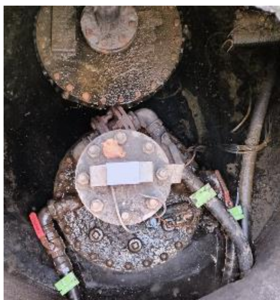
Рисунок 3 – Маркировочная табличка и горловины резервуара РГС-50 зав.№ 147
