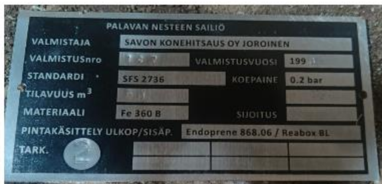
Рисунок 3 – Маркировочная табличка и горловины резервуара РГС-50 зав.№ 147
