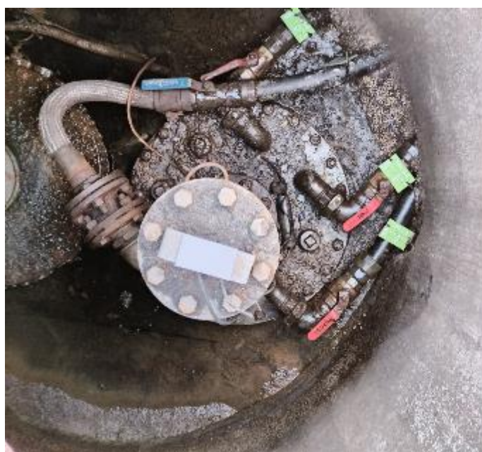
Рисунок 2 – Маркировочная табличка и горловины резервуара РГС-50 зав.№ 146
