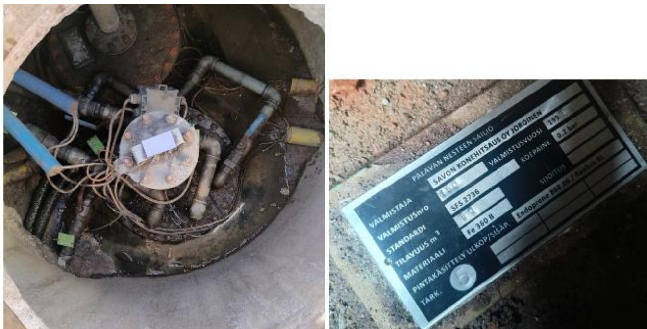
Рисунок 6 – Маркировочная табличка и горловины резервуара РГС-50 зав.№ 150
