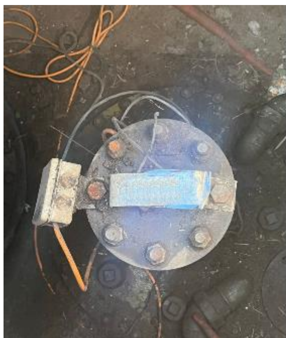
Рисунок 2 – Маркировочная табличка и горловина резервуара РГС-30 зав.№ 557
