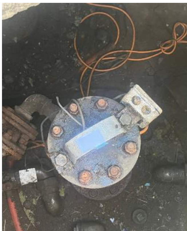
Рисунок 4 – Маркировочная табличка и горловина резервуара РГС-30 зав.№ 559
