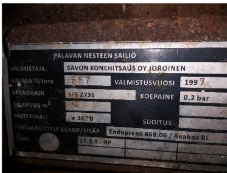
Рисунок 2 – Маркировочная табличка и горловина резервуара РГС-30 зав.№ 557
