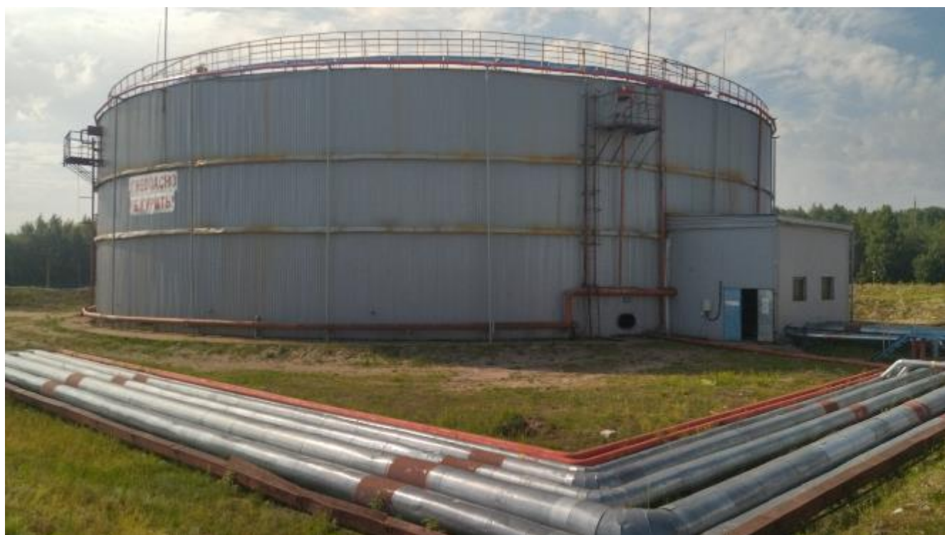
Рисунок 2 – Общий вид резервуара РВС-20000 № 2
