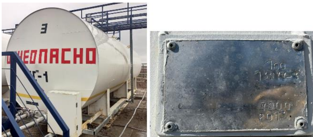
Рисунок 4 – Общий вид резервуара и маркировочной таблички РГС-100 зав. № 13977-3
