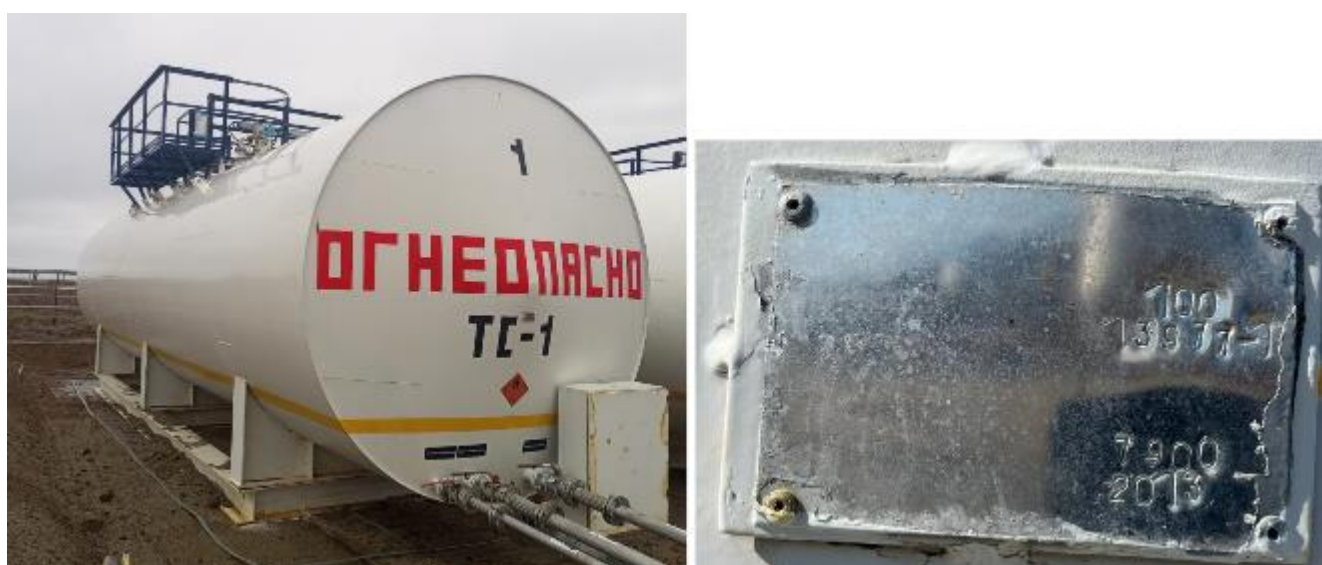
Рисунок 2 – Общий вид резервуара и маркировочной таблички РГС-100 зав. № 13977-1
