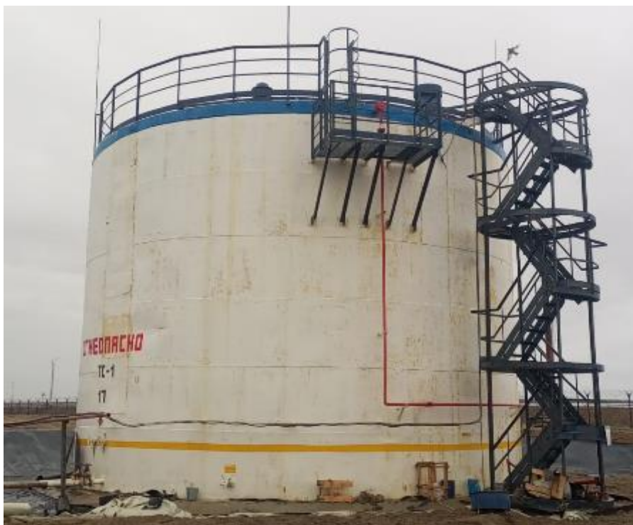
Рисунок 5 – Общий вид резервуара РВС-1000 № 17
