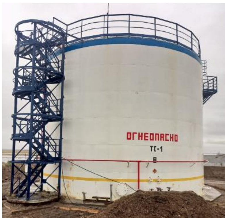
Рисунок 1 – Общий вид резервуара РВС-1000 № 8
