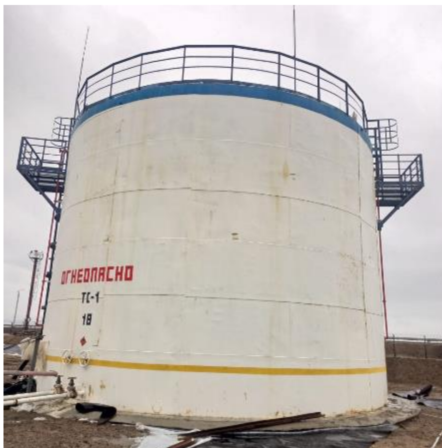
Рисунок 6 – Общий вид резервуара РВС-1000 № 18
