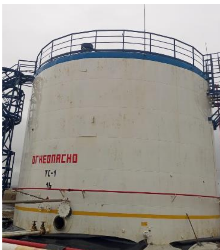
Рисунок 4 – Общий вид резервуара РВС-1000 № 16
