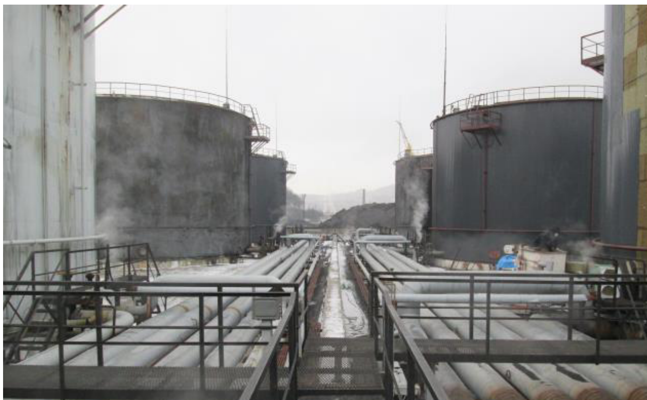
Рисунок 1 – общий вид резервуаров стальных вертикальных цилиндрических PVC-3000
