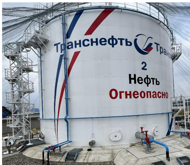
Рисунок 1 – Общий вид резервуара
