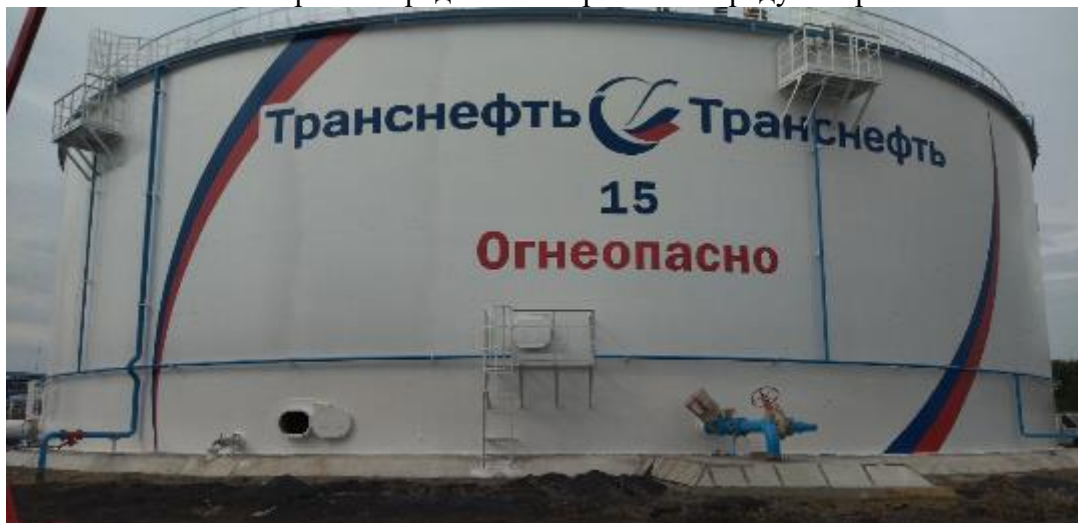
Рисунок 1 – Общий вид резервуара РВСП-20000 № 15
