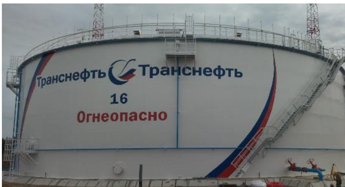
Рисунок 2 – Общий вид резервуара РВСП-20000 № 16
