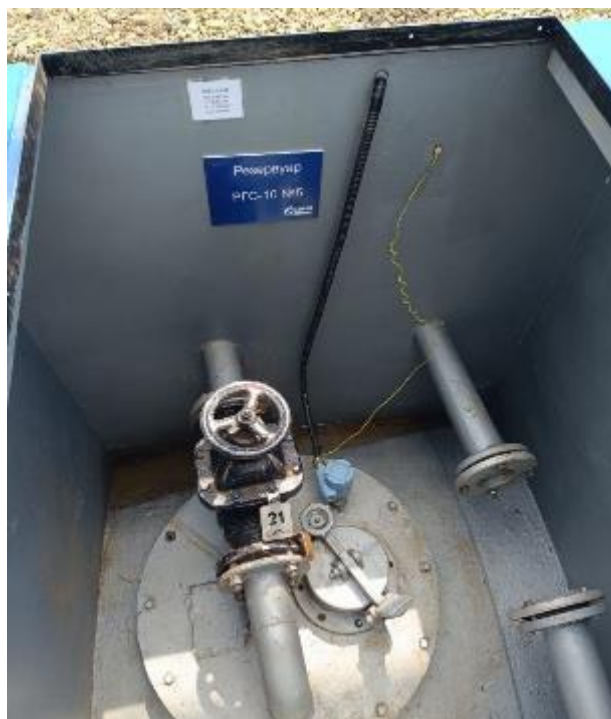
Рисунок 4. Место нанесения заводского номера резервуара РГС-10 № 5
