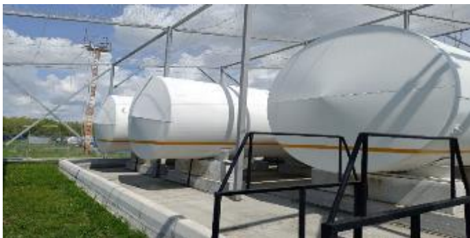
Рисунок 1. Общий вид резервуаров РГС-65 № 1 и № 2, РГС-75 № 3
