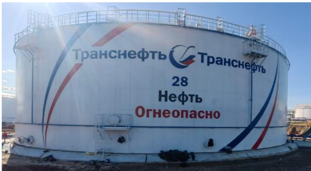
Рисунок 3 – Общий вид резервуара РВСП-20000 № 28
