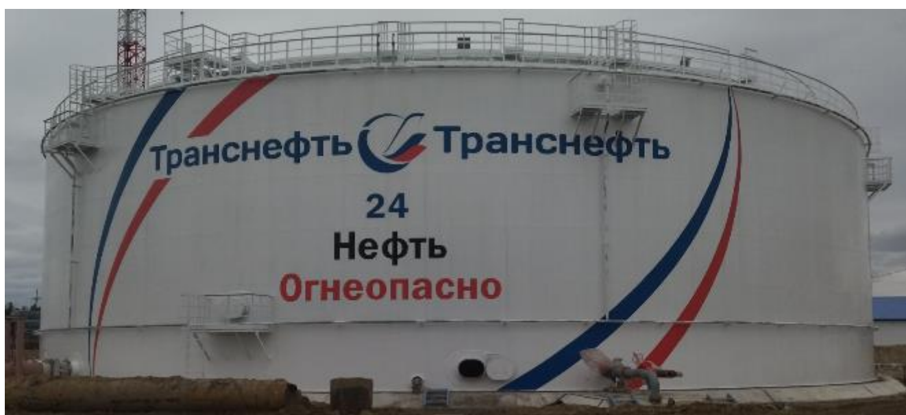
Рисунок 2 – Общий вид резервуара РВСП-20000 № 24
