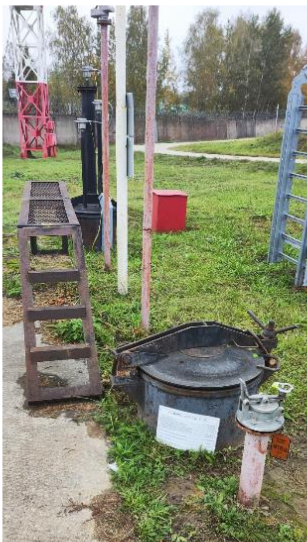
Рисунок 3 – Горловины резервуара РГСП-160 зав.№ 9
