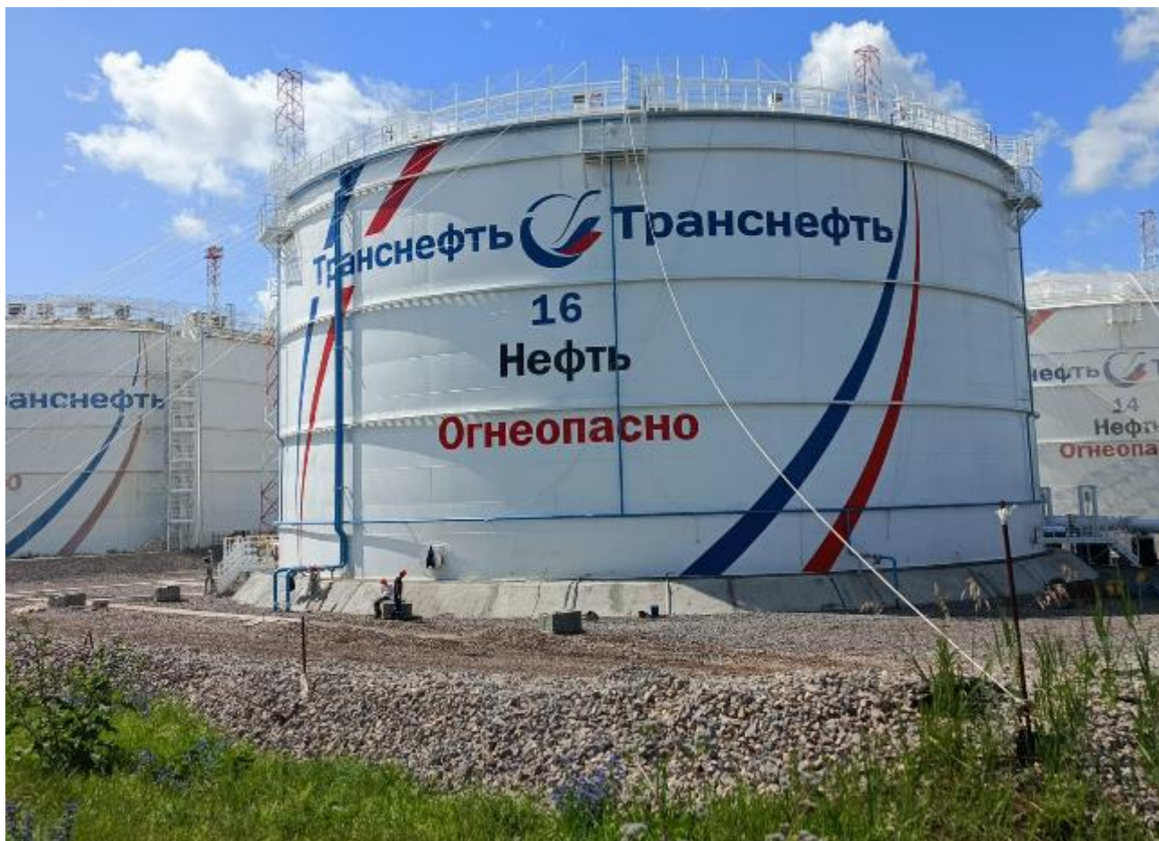
Рисунок 1 – Общий вид резервуара РВСП-20000 № 16
