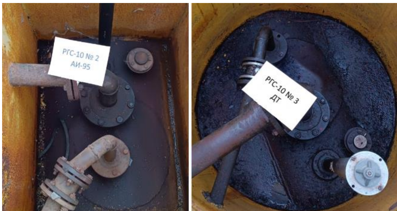
Рисунок 2 – Горловины резервуаров РГС-10 зав.№№ 2, 3
