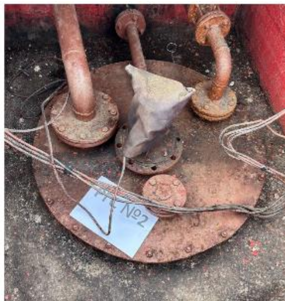
Рисунок 2 – Горловины резервуаров РГС-50 зав.№№ 1, 2
