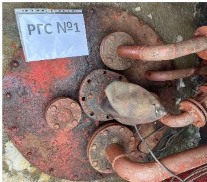
Рисунок 2 – Горловины резервуаров РГС-50 зав.№№ 1, 2
