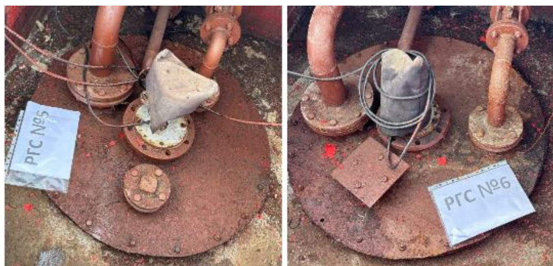
Рисунок 4 – Горловины резервуаров РГС-50 зав.№№ 5, 6
