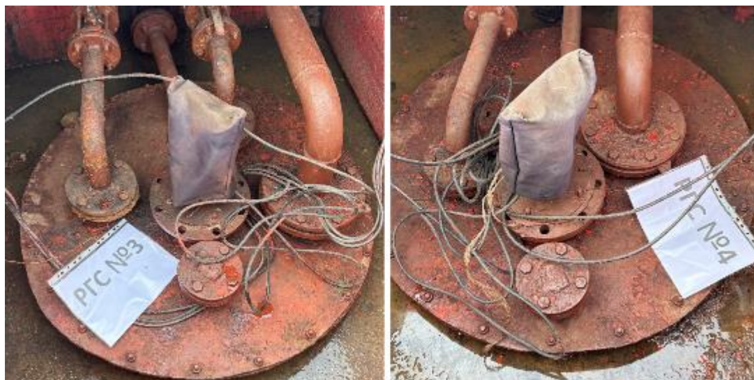
Рисунок 3 – Горловины резервуаров РГС-50 зав.№№ 3, 4
