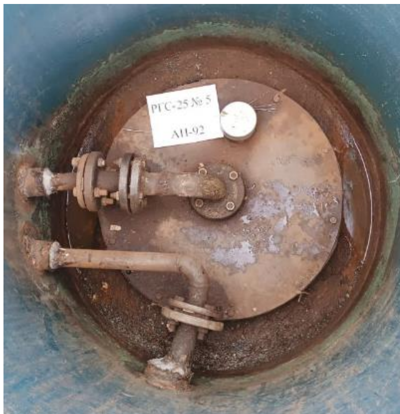
Рисунок 3 – Горловина резервуара РГС-25 зав.№ 5
