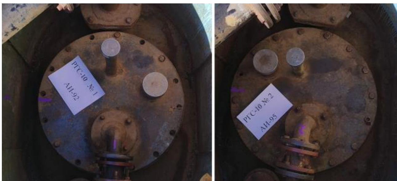
Рисунок 2 – Горловины резервуаров РГС-10 зав.№№ 1, 2
