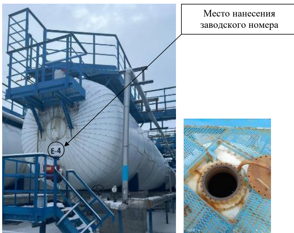
Р и с у н о к 2 – Общий вид резервуара с заводским номером Е-4 и его замерного люка
