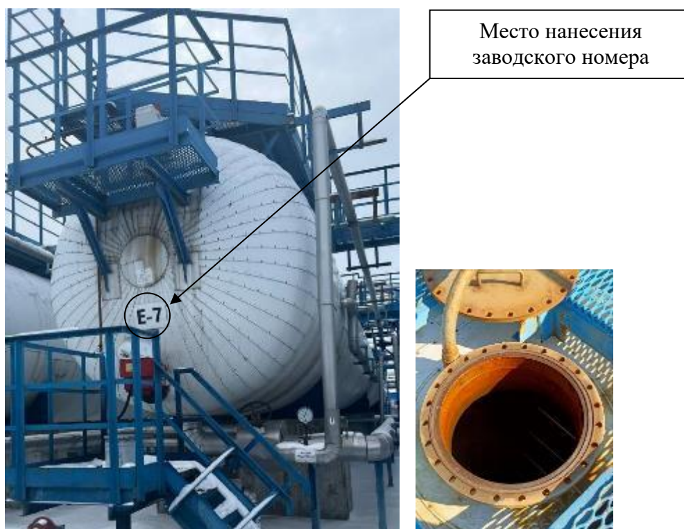
Р и с у н о к 4 – Общий вид резервуара с заводским номером E-7 и его замерного люка
