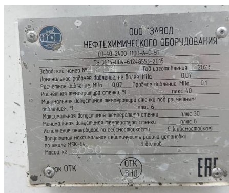
Рисунок 2 – Общий вид таблички с заводским номером и место установки резервуара горизонтального стального РГС-40-2400-1100-А-СО-У1 (заводской номер № 4254)
