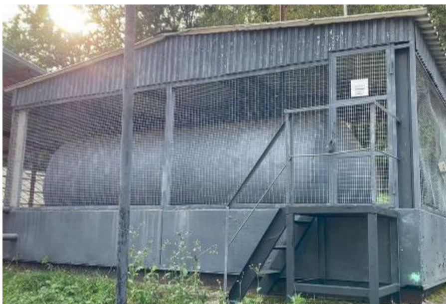
Рисунок 1 – Общий вид резервуара горизонтального стального РГС-15
