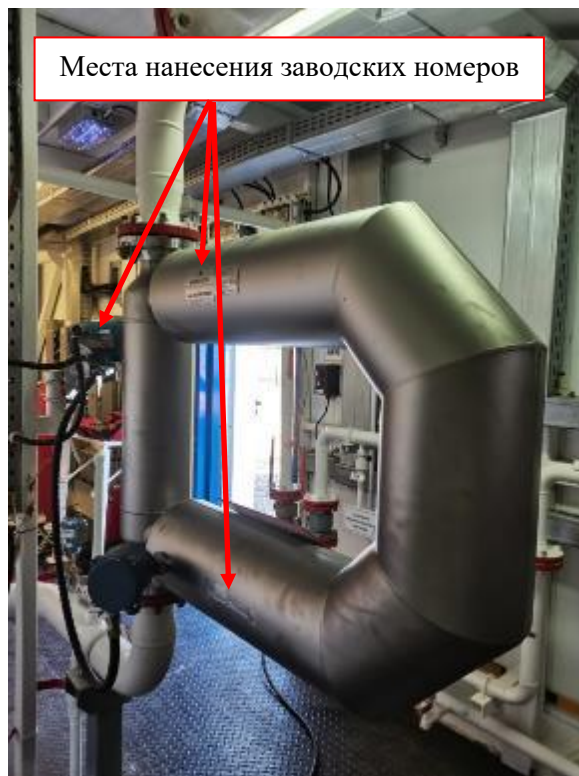
Рисунок 1 – Общий вид счетчиков-расходомеров и места нанесения заводских номеров
