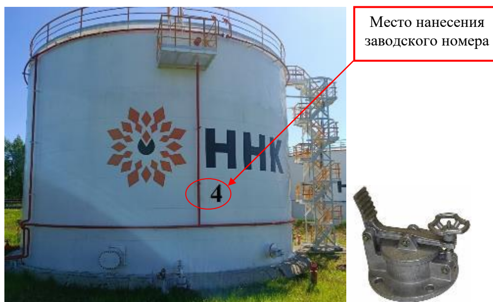
Рисунок 3 – Общий вид резервуара и замерного люка РВС-3000 зав. № 4
