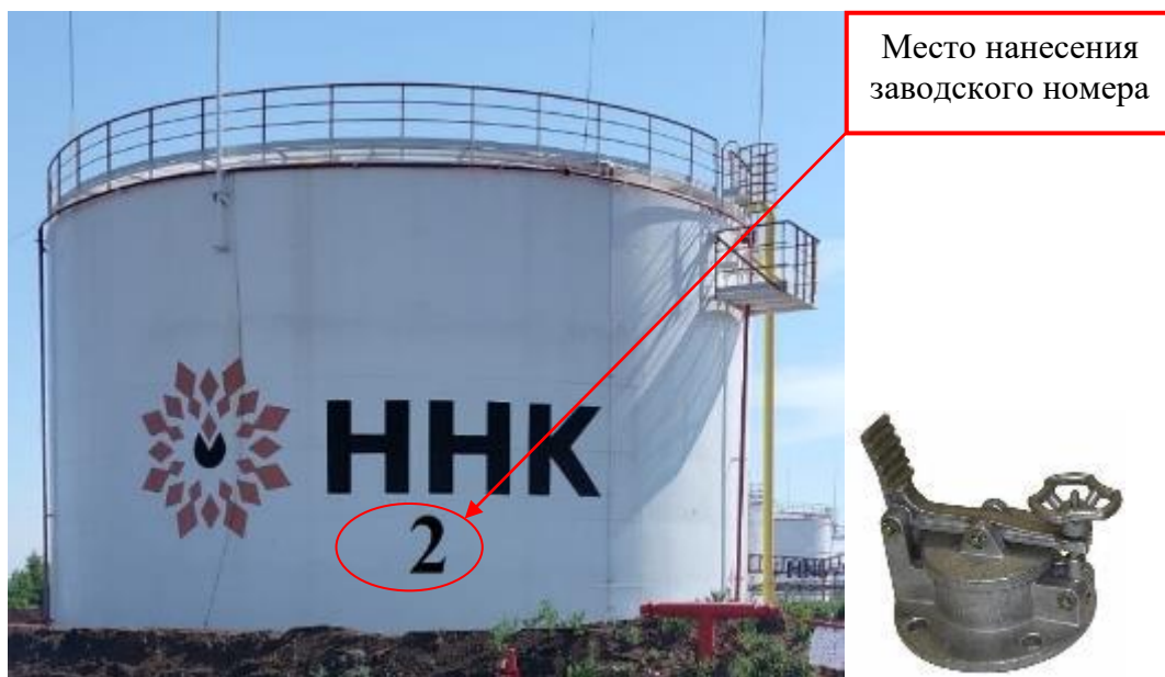
Рисунок 1 – Общий вид резервуара и замерного люка РВС-3000 зав. № 2
