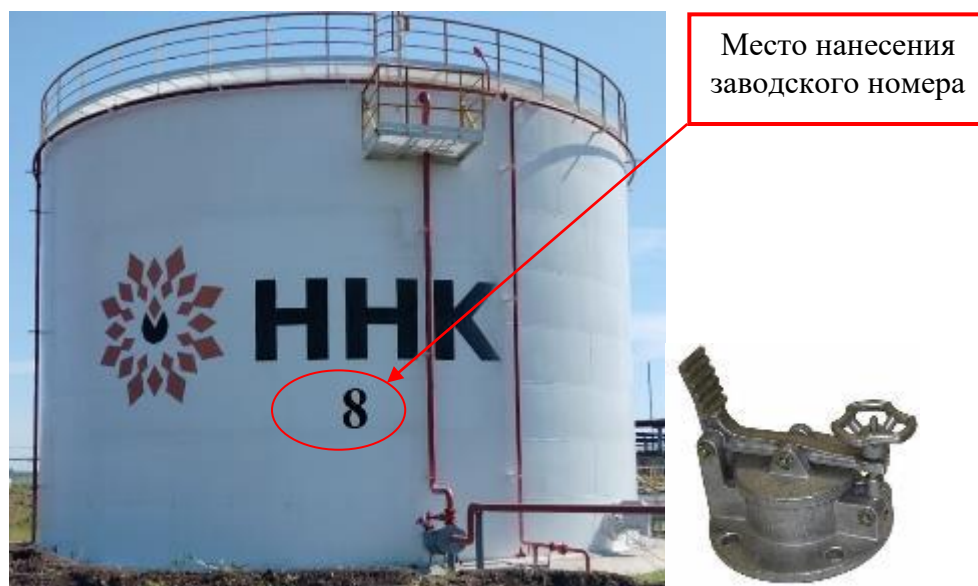
Рисунок 4 – Общий вид резервуара и замерного люка РВС-3000 зав. № 8
