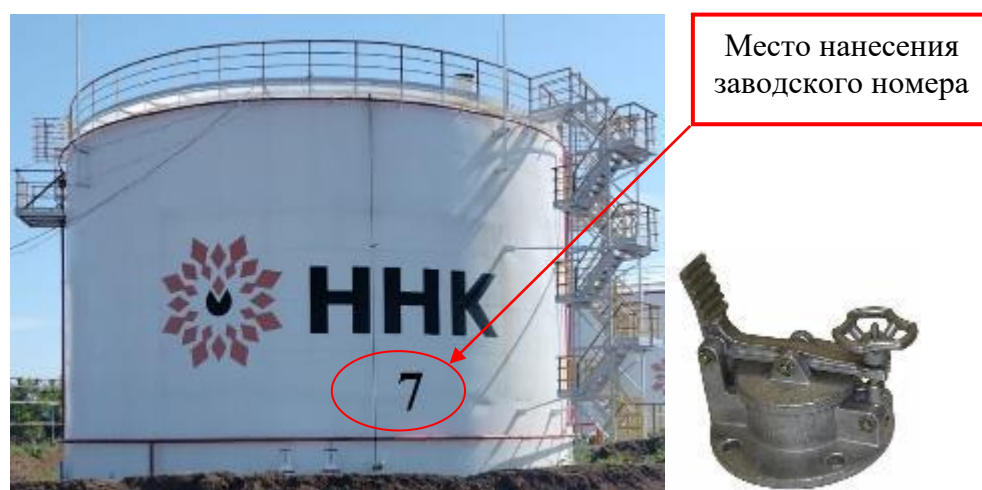
Рисунок 3 – Общий вид резервуара и замерного люка РВС-3000 зав. № 7
