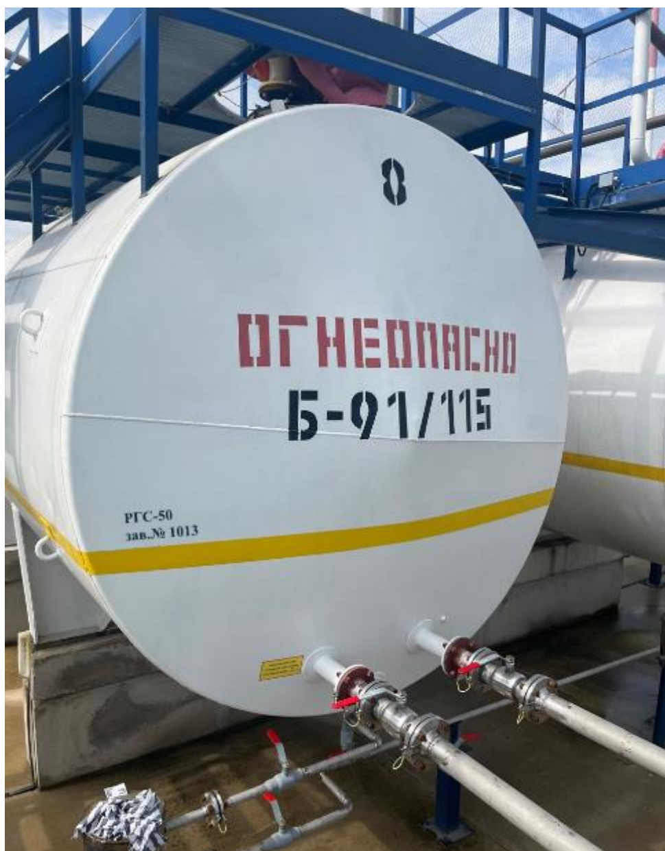
Рисунок 1 – Общий вид резервуара РГС-50
