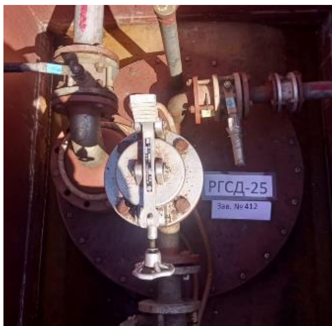
Рисунок 3 – Горловина и измерительный люк резервуара РГСД-25 зав.№ 412
