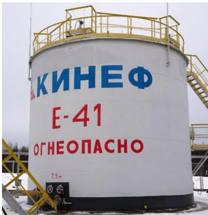
Рисунок 1 – Общий вид резервуара РВСП-400 зав.№ Е-41
