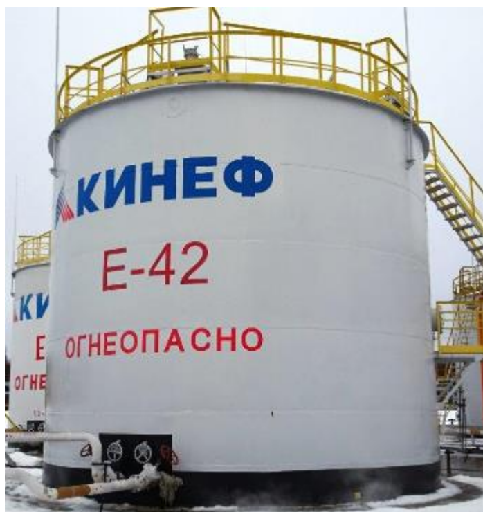
Рисунок 2 – Общий вид резервуара РВСП-400 зав.№ Е-42
