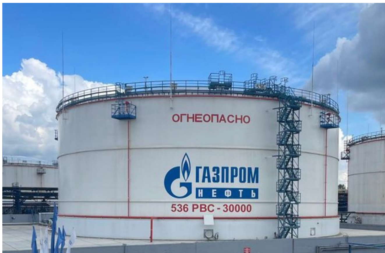
Рисунок 1 – Общий вид резервуара РВС-30000 №536
