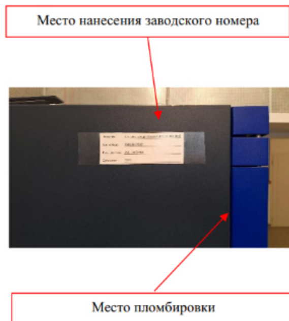
Рисунок 2 – Место нанесения заводского номера на шкафу системы управления PUMA
