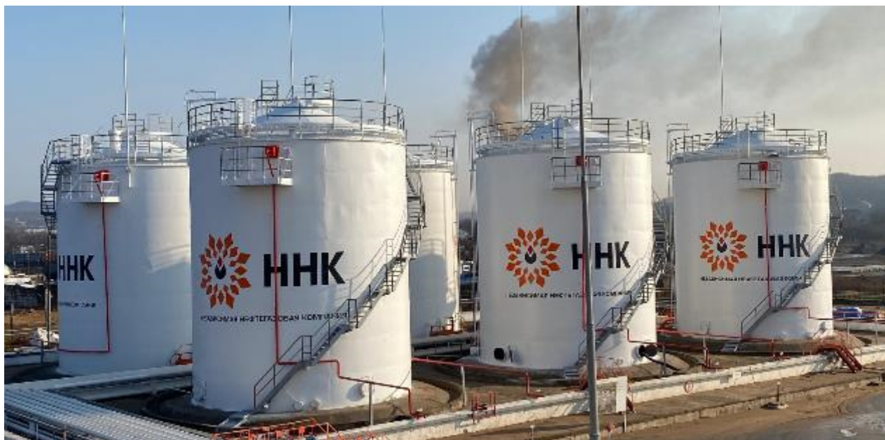
Рисунок 1 – Общий вид резервуаров вертикальных стальных цилиндрических РВС-1000 зав.№№ 628 (тех. 5), 629 (тех. 4), 630 (тех. 2), 631 (тех.6)
