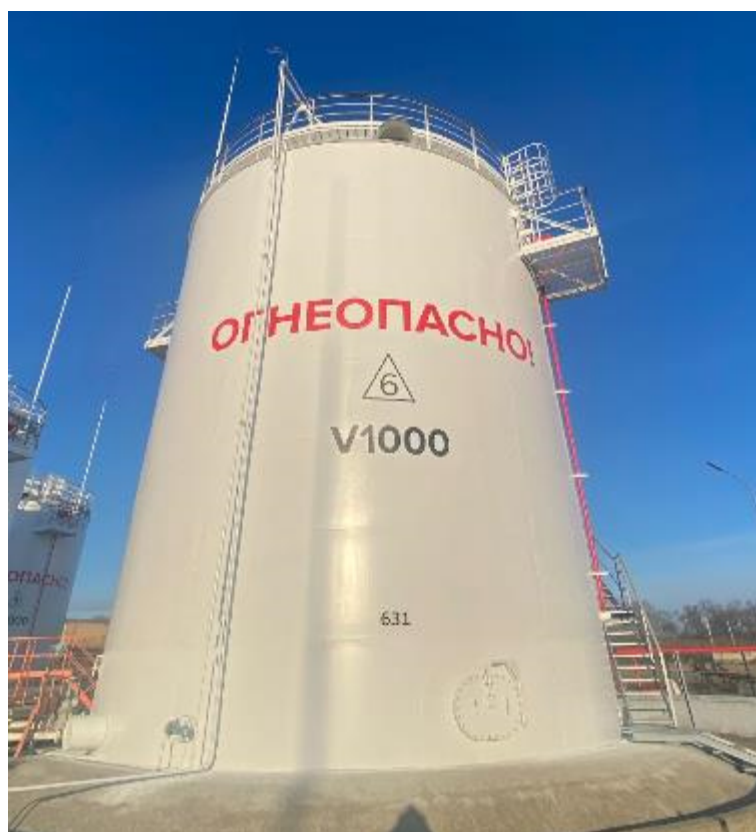
Рисунок 2 – Место нанесения заводского и технологического номеров РВС-1000
