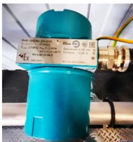
Рисунок 13 – Датчик давления ЭНИ-100-ВН-ДИ в месте установки
