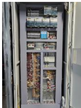
Рисунок 4 – Шкаф кроссовый измерений ШКИ
