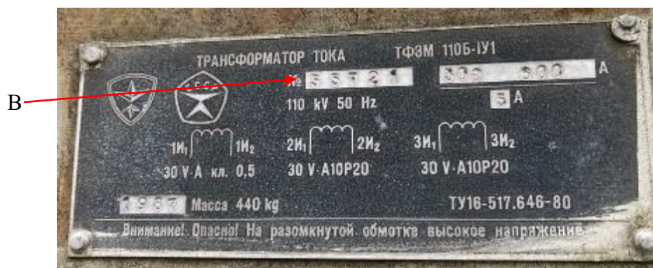
Рисунок 2 – Обозначение места нанесения заводского номера (В)
