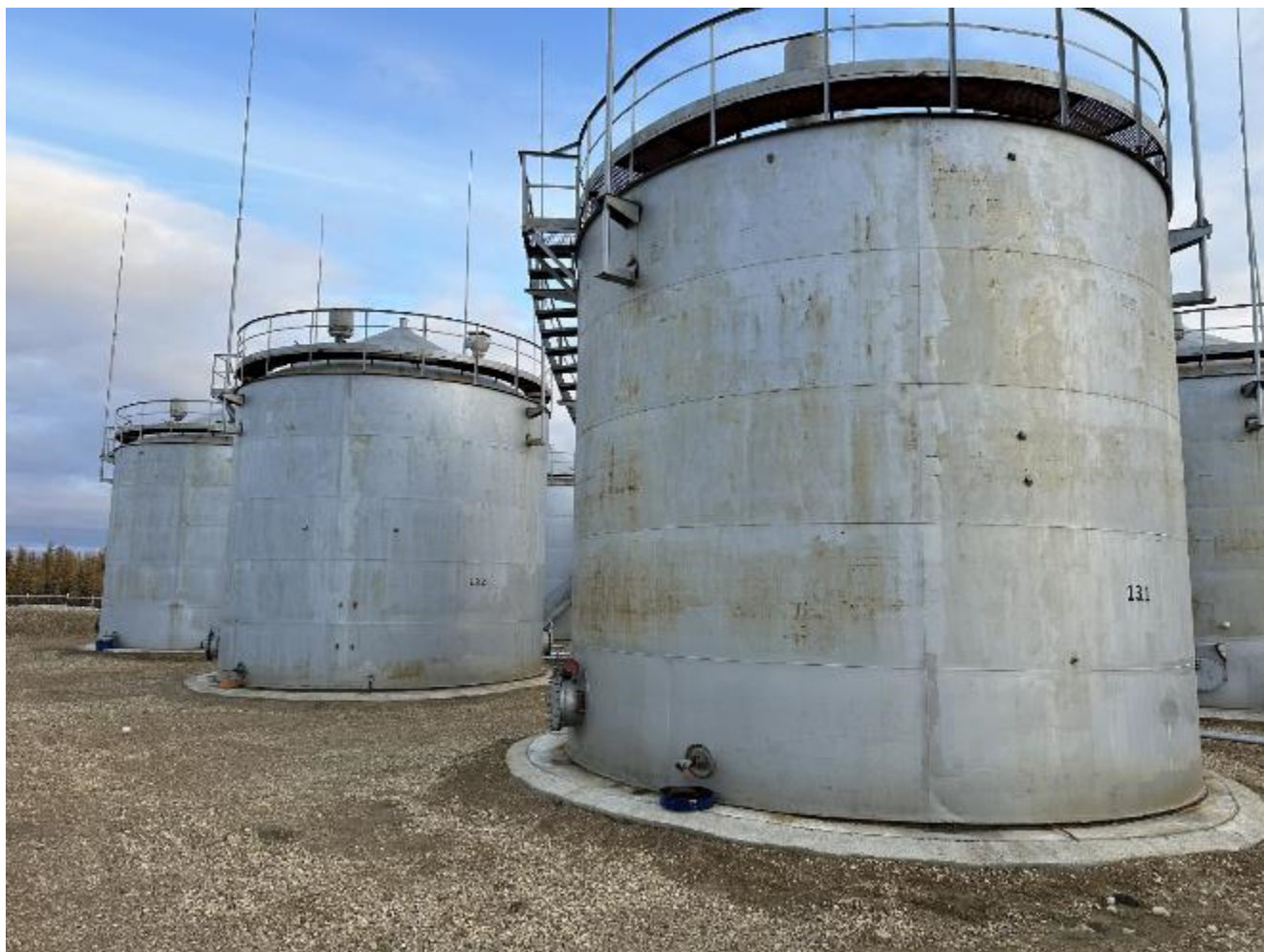
Рисунок 3 – Общий вид резервуаров вертикальных стальных цилиндрических РВС-400, зав.№№ 1.3.1, 1.3.2, 1.3.3 с указанием места нанесения заводских номеров
