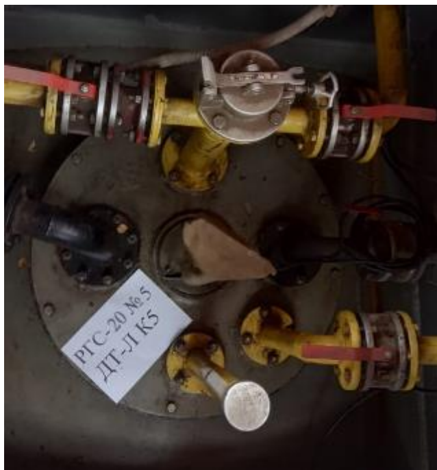
Рисунок 4 – Горловина резервуара РГС-20 зав.№ 5
