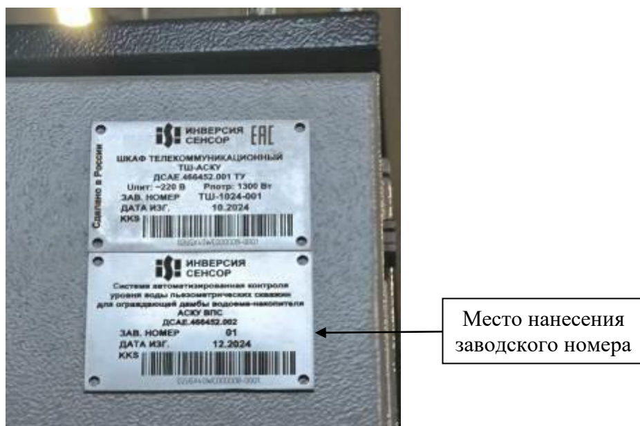
Рисунок 2 – Общий вид информационной таблички, прикрепленной к телекоммуникационному шкафу системы с указанием места нанесения заводского номера
