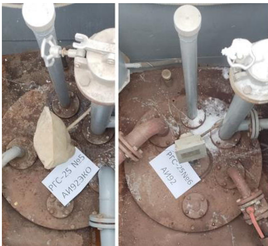
Рисунок 3 – Горловины резервуаров РГС-25 зав.№№ 5, 6
