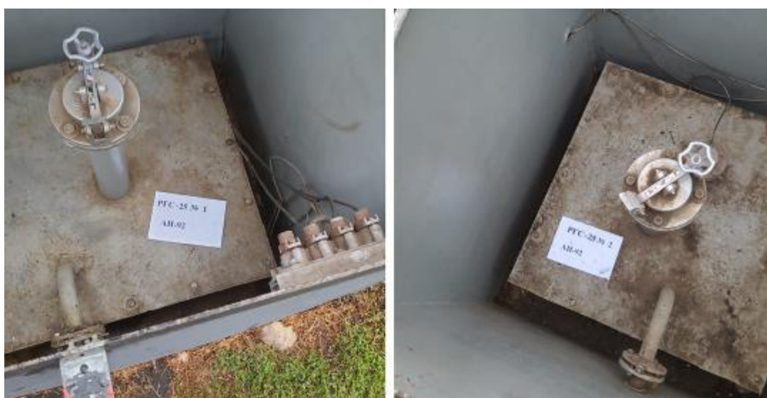
Рисунок 3 – Горловины резервуаров РГС-25 зав.№№ 1, 2
