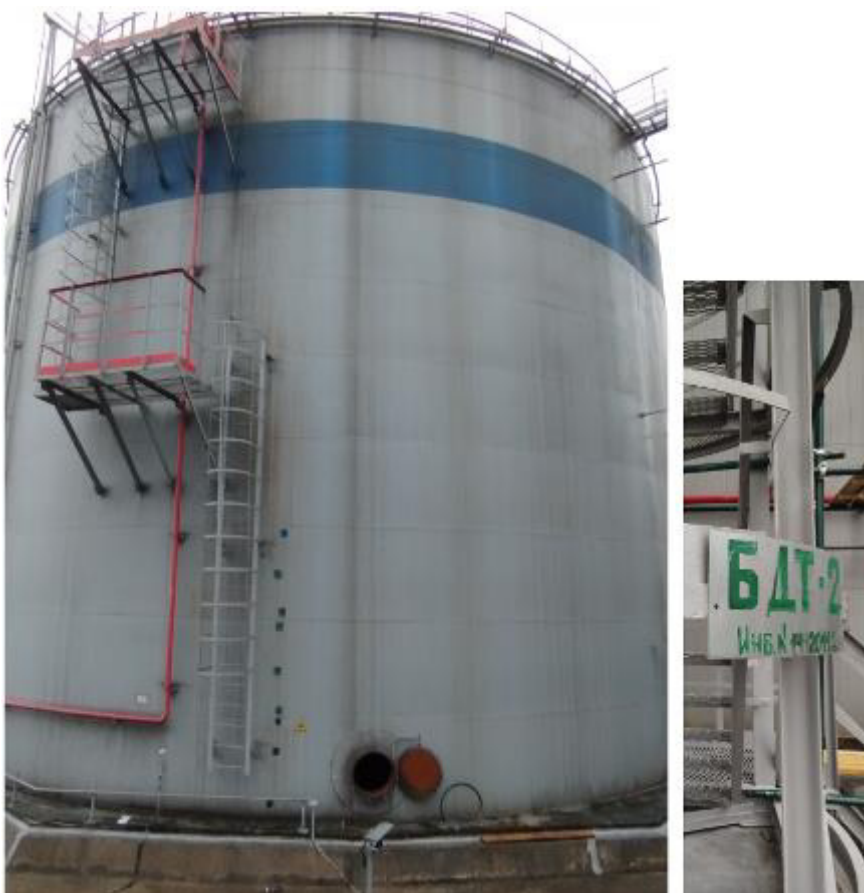
Рисунок 2 – Общий вид резервуара РВС-5000 зав.№ БДТ-2
