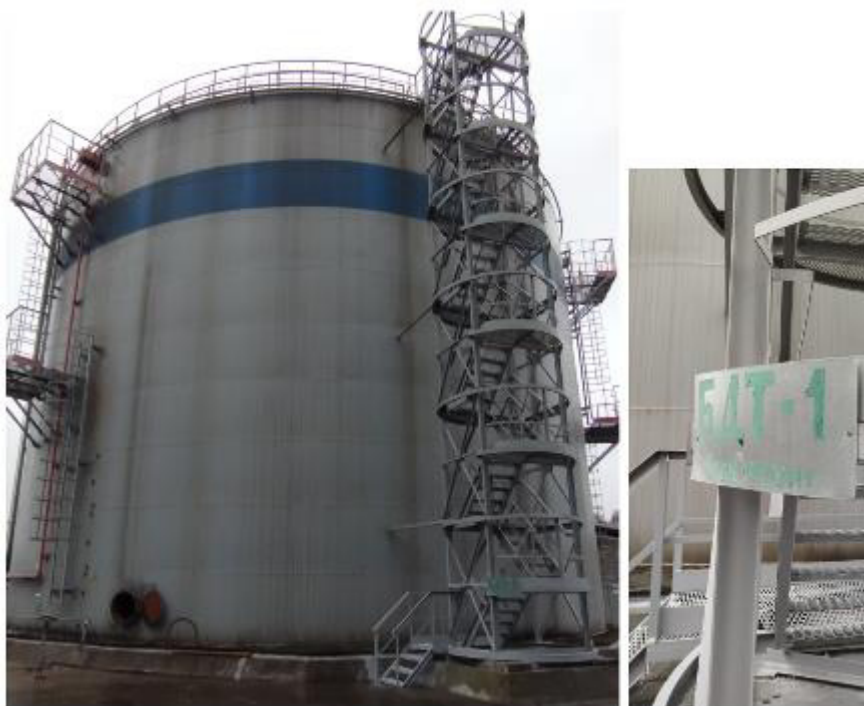
Рисунок 1 – Общий вид резервуара РВС-5000 зав.№ БДТ-1
