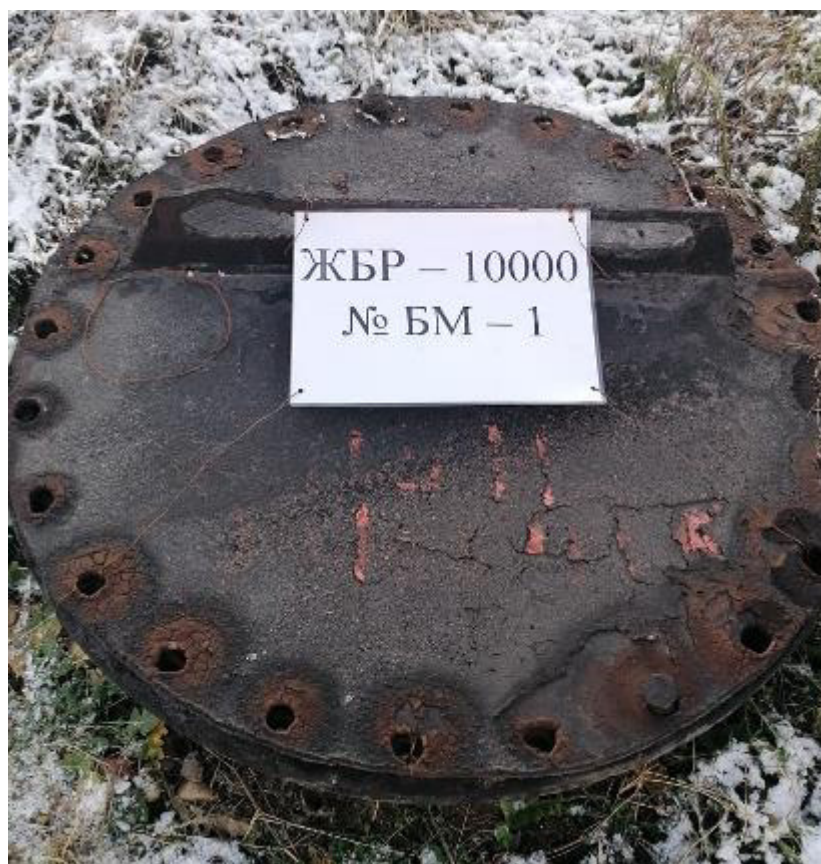
Рисунок 2 – Горловина резервуара ЖБР-10000 № БМ-1
