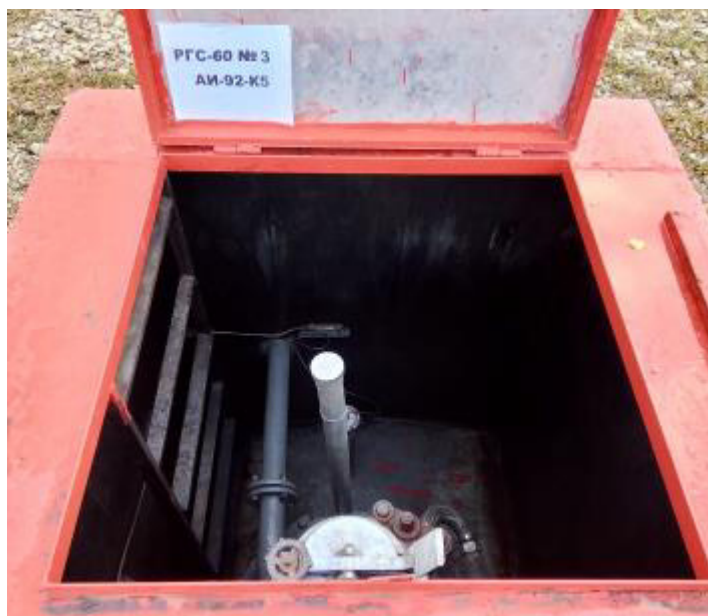
Рисунок 4 – Горловина резервуара РГС-60 зав.№ 3
