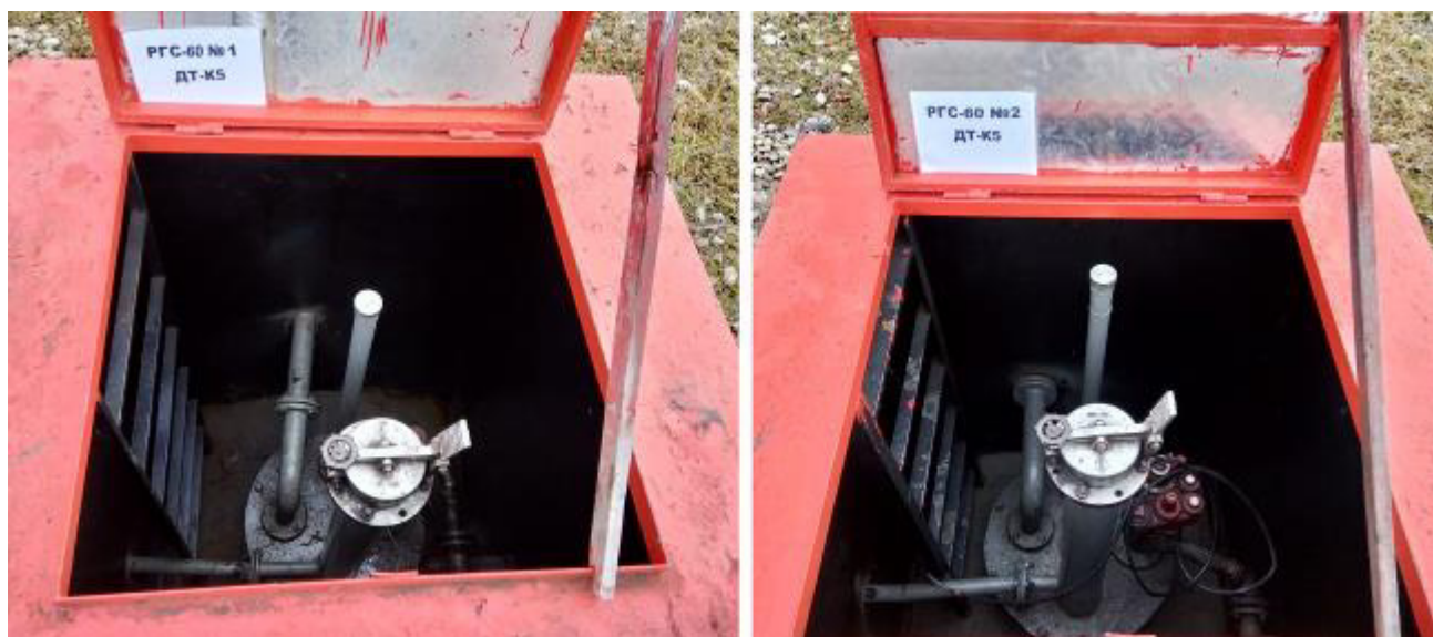
Рисунок 3 – Горловины резервуаров РГС-60 зав.№№ 1, 2
