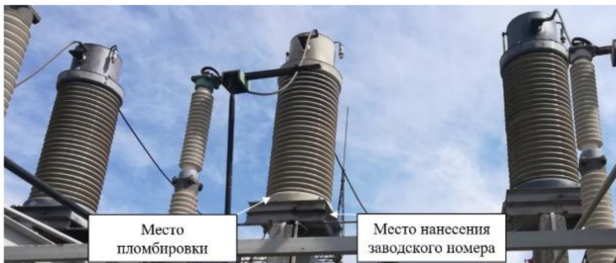
Рисунок 1 – Общий вид средства измерений с указанием места пломбировки, места нанесения заводского номера
