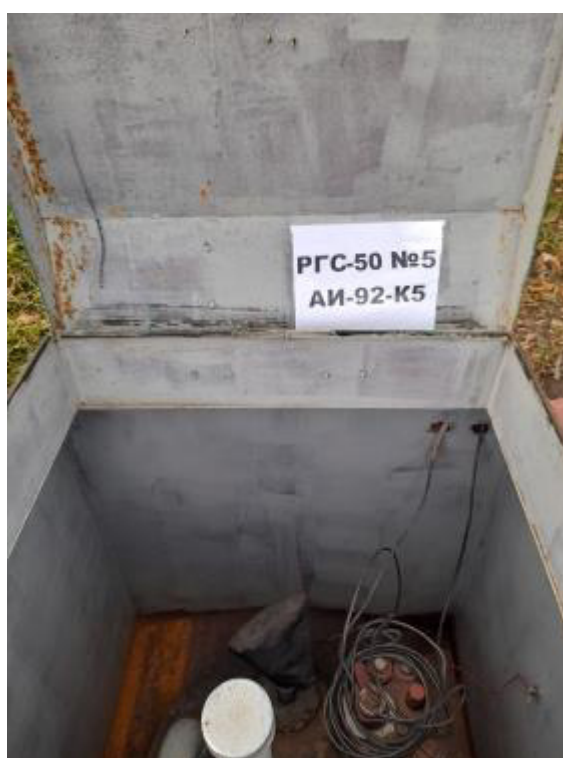
Рисунок 4 – Горловина резервуара РГС-50 зав.№ 5
