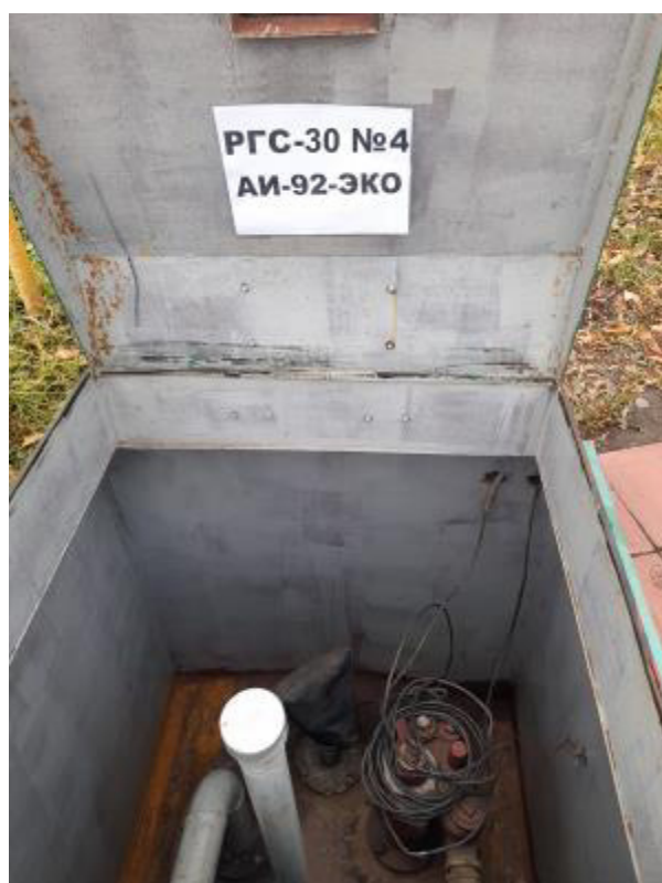
Рисунок 2 – Горловина резервуара РГС-30 зав.№ 4
