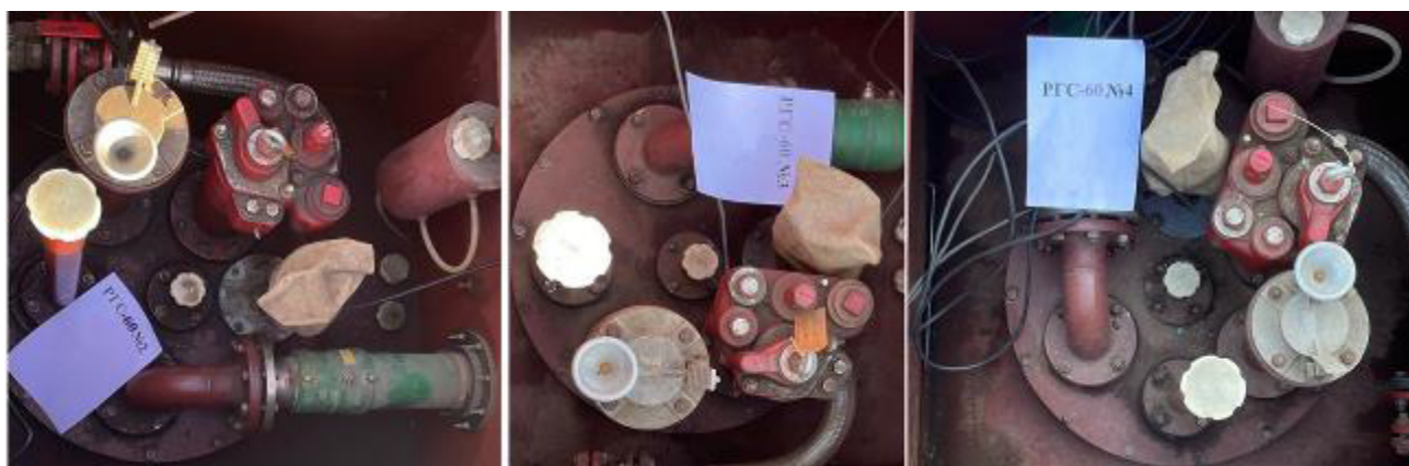
Рисунок 4 – Горловины резервуаров РГС-60 зав.№№ 2, 3, 4
