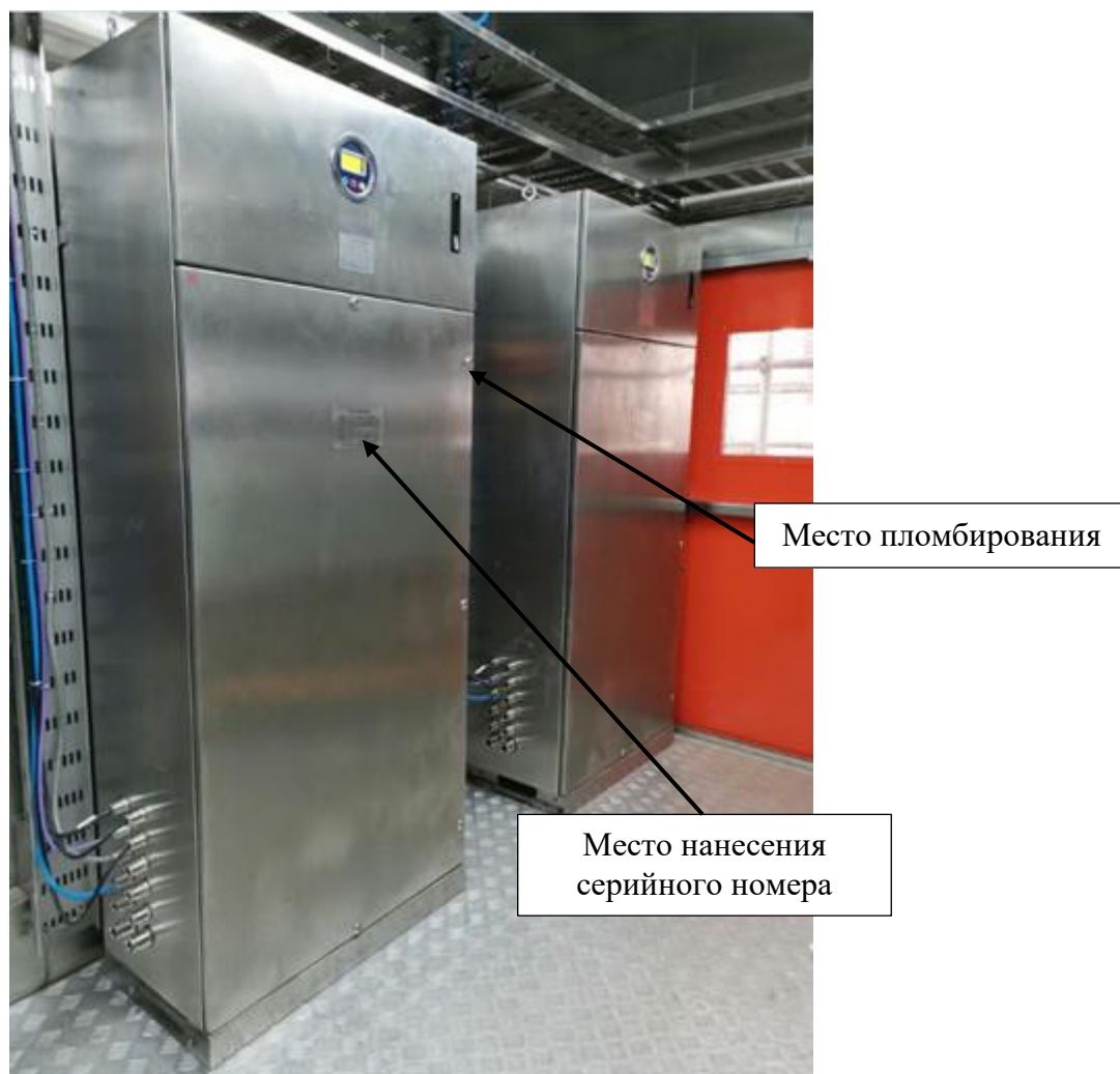
Рисунок 1 – Общий вид и схема маркировки спектрометра
