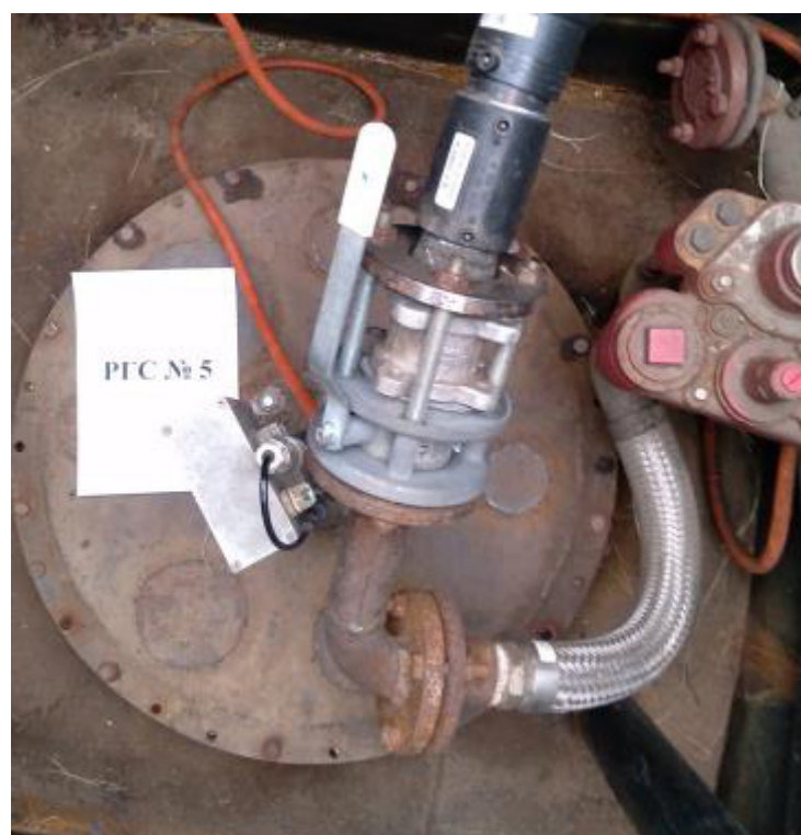
Рисунок 4 – Горловина резервуара РГС-40 зав.№ 5
