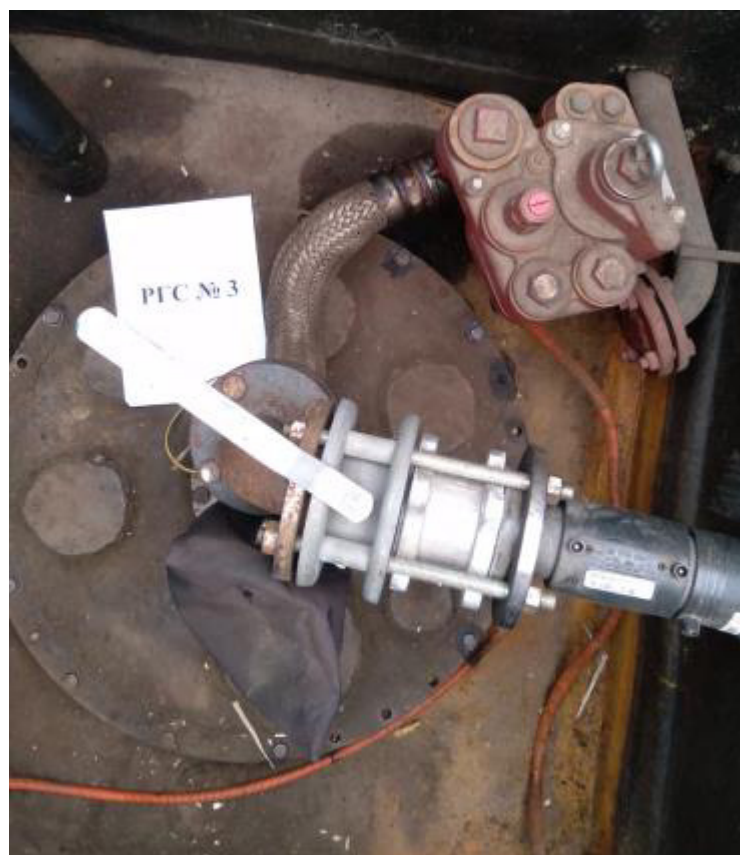
Рисунок 3 – Горловина резервуара РГС-20 зав.№ 3
