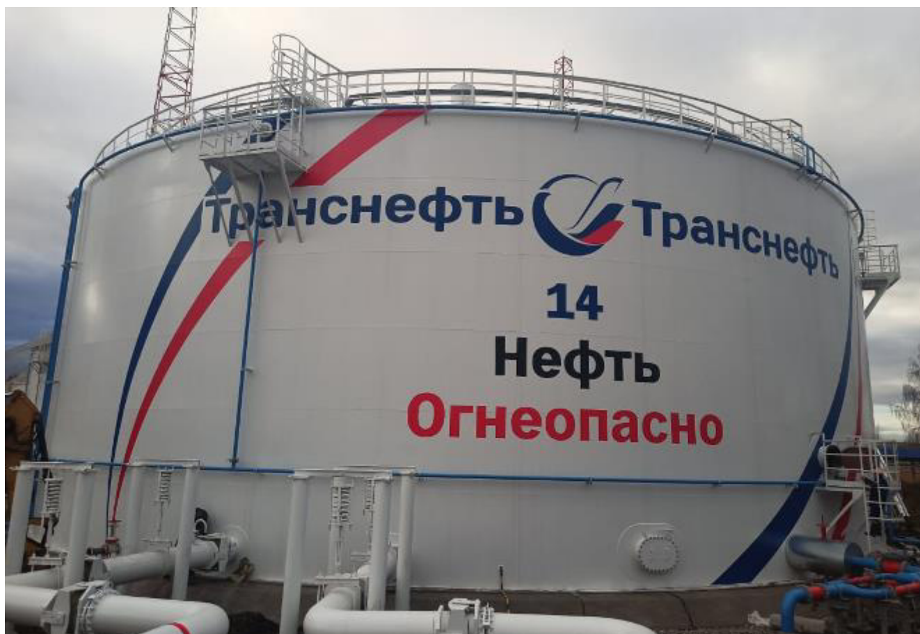
Рисунок 1 – Общий вид резервуара РВСП-10000 № 14
