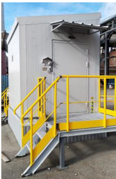
Рисунок 1 – Общий вид блок-бокса, в котором размещен газоаналитический комплекс MCS100FT и ИВК
